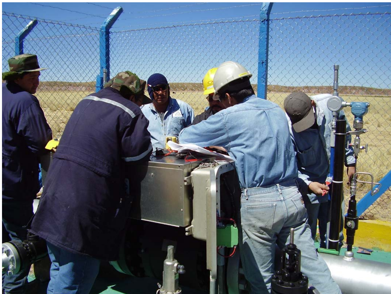
Foto 7.- Comisionando el actuador de la Válvula
