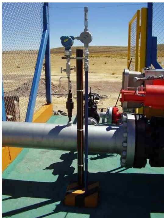
Foto 3. Instalación de instrumentos y tubing en la válvula.
