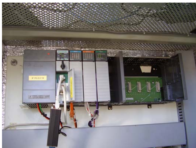
Foto 6. Vista de las protecciones del PLC y Panel View
