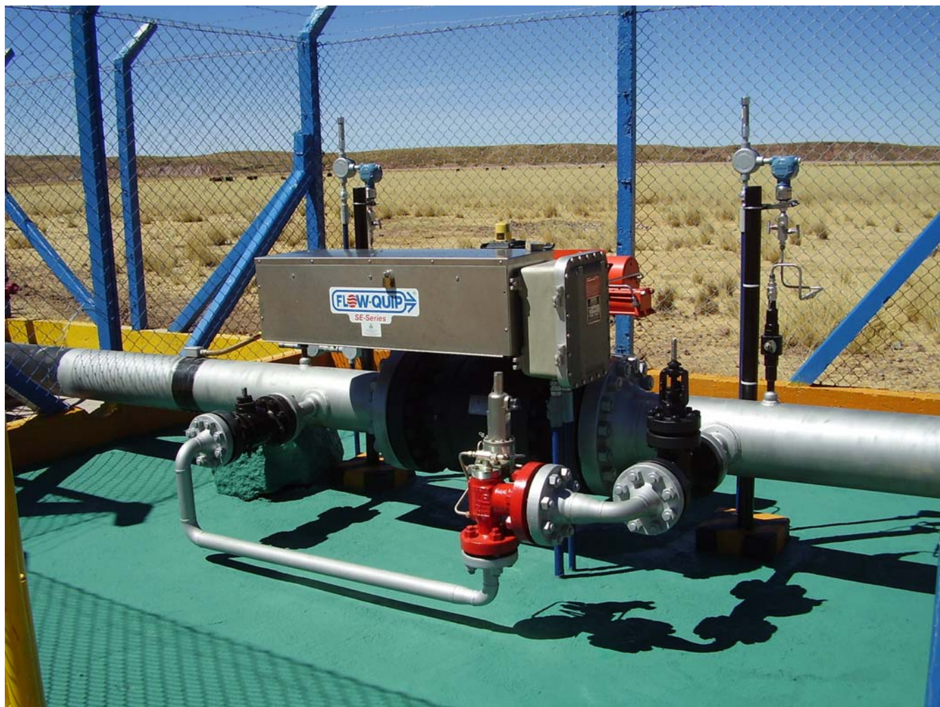
Foto 2.- Válvula e Instrumentación
