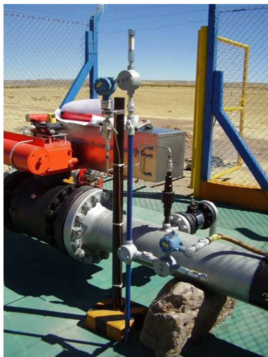
Foto 3. Instalación de instrumentos y tubing en la válvula.
