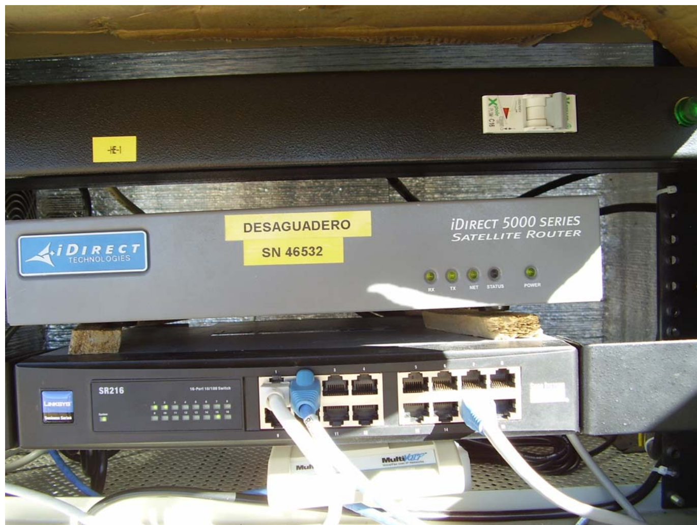
Foto 9.- Foto del rack de equipos de comunicación satelital
